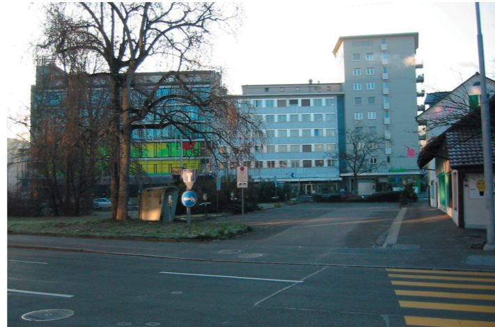
Der Bereich des potentiellen Stadtplatzes von der Bahnhofstrasse aus gesehen
