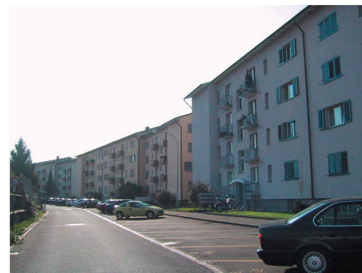
Siedlungsbauten Badenerstrasse am Kesslerplatz
